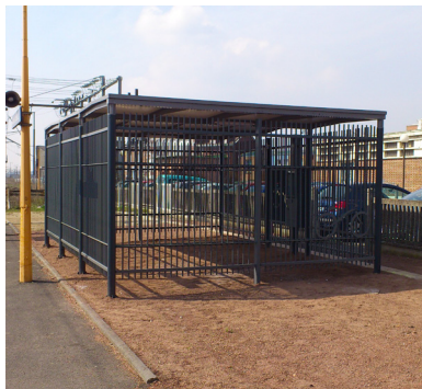
Stationnement vélo sécurisé à la gare d'Aulnoye-Aymeries
